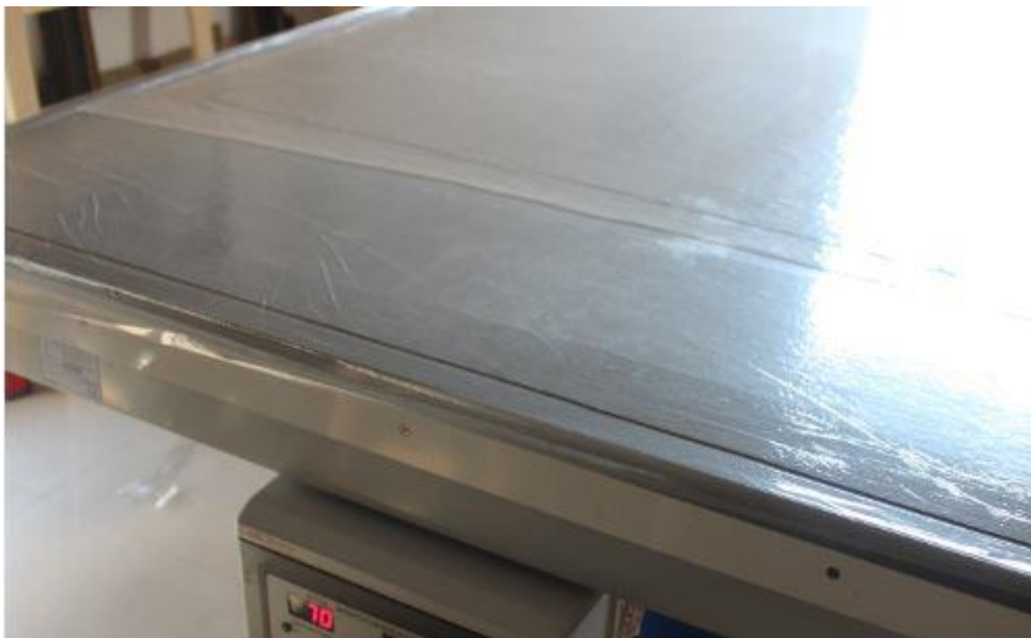
Dublowanie obrazu płótnem lnianym /dodanie nowego nośnika płóciennego/ w celu wzmocnienia „starego” podobrazia.
